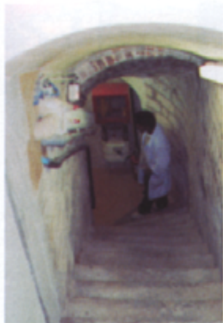
W starożytnych piwnicach mieszczą się urządzenia techniczne
