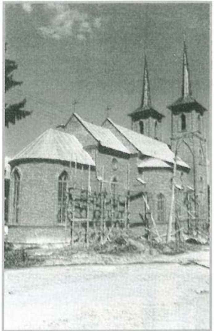
Nowa Uszyca - kościół p.w. Przemienienia Pana Jezusa z 1861 r., zniszczony całkowicie w latach 60., obecnie odbudowany
