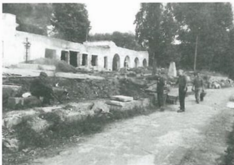
Prace porządkowe na Cmentarzu Orląt - odgruzowanie kwatery nr 2 (stan z 1995 r.)
