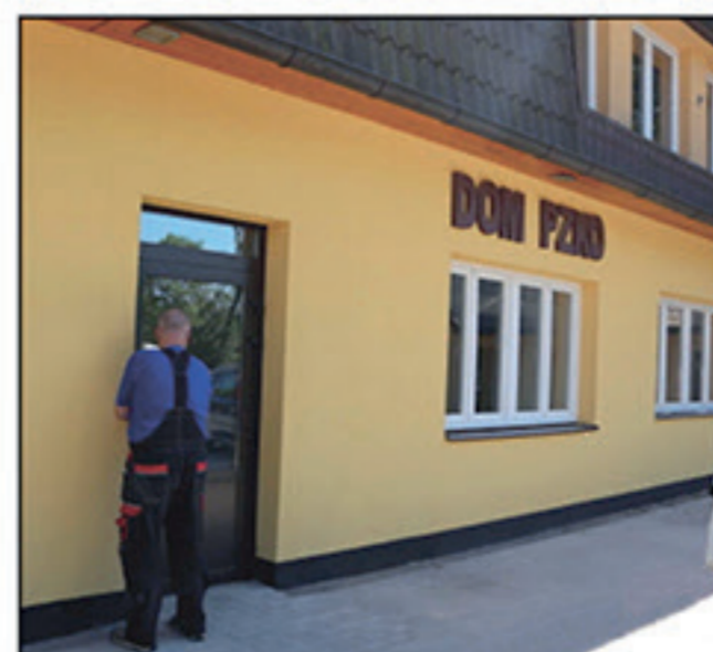
Dom Polski PZKO w Bystrzycy w trakcie pierwszego etapu remontu
