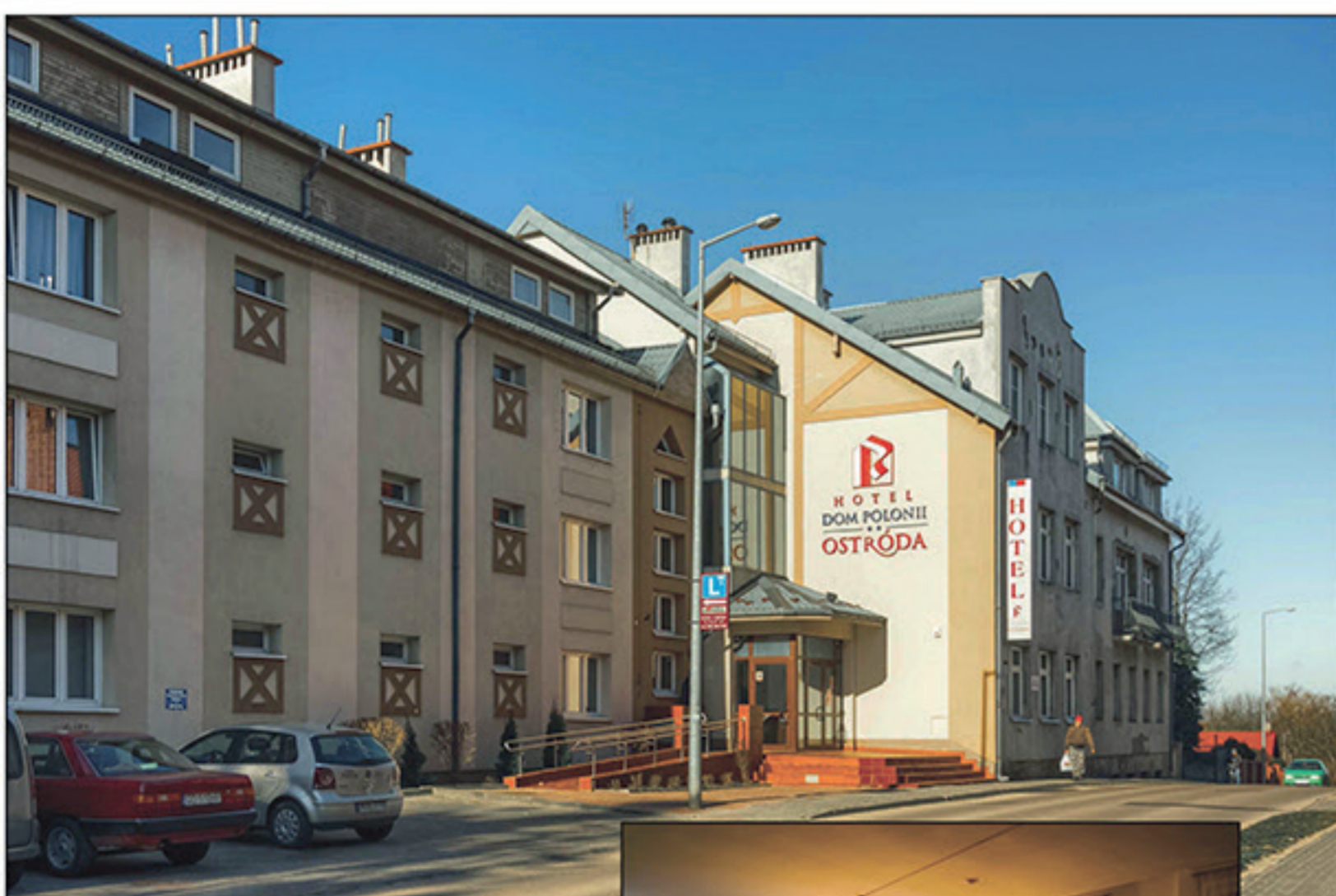
Budynek Hotelu Dom Polonii w Ostródzie
